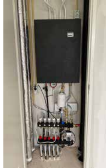
De afleverset van de warmtepomp
