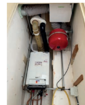
MV-box in kast geplaatst
