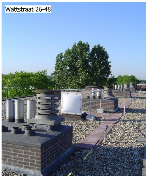
Fig. 1 Toegang middels lichtkoepel. Bij uitstap hekwerk rondom ten behoeve van vluchtweg en rode tegels met markeringsketting. Let op valgevaar bij openstaande lichtkoepel. Na betreding dak de lichtkoepel altijd sluiten.
