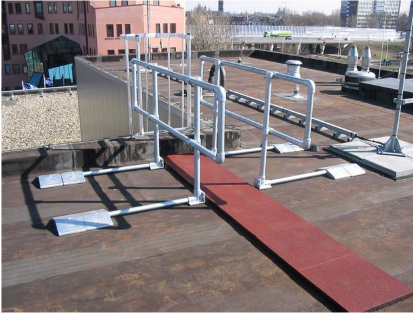
Fig. 10 voorbeeld van tegelpadmarkering op dak
