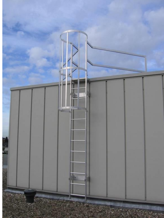
fig. 9 permanente kooiladder
