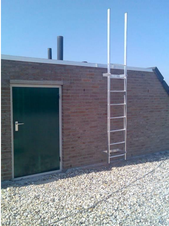
Fig. 8 permanente ladder
