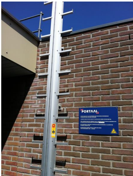
Fig. 16 voorbeeld klapbare mastladder
