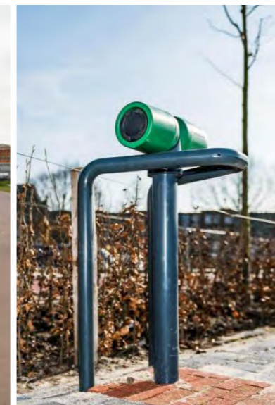
laadvoorzieningen voor elektrische auto's - combinatie met openbare verlichting
