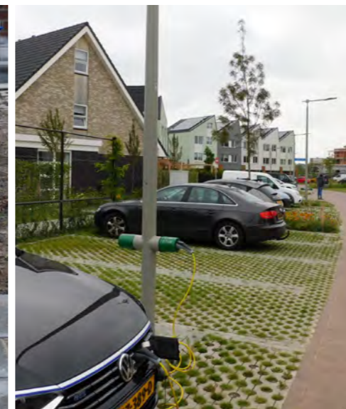
laadvoorzieningen voor elektrische auto's - combinatie met openbare verlichting
